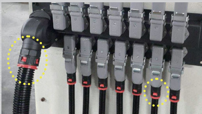
尼龍配電軟管及快速接頭 (使用例)
