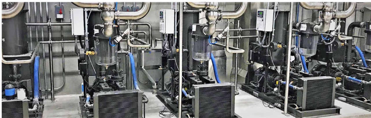
▲ 目前在高科技產業的半導體與光電廠務設施中，均由多部大小不同馬力的真空泵組成，並藉由多機聯鎖系統，保持系統真空壓力在特定合理範圍內使用。(source: rag.no)
